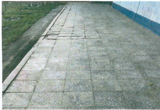
Foto 2: Mejoramiento de piso en pasillo y Baños del Modulo 4
