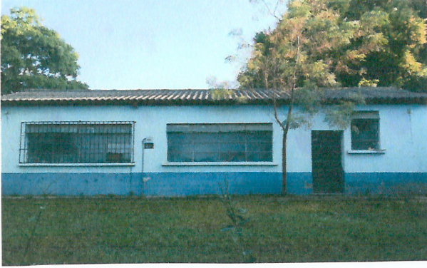
Foto 1: Sustitución de Techo Del Modulo 3 a Laminado Truquelada calibre 26 y mejoramiento de estructura portante
